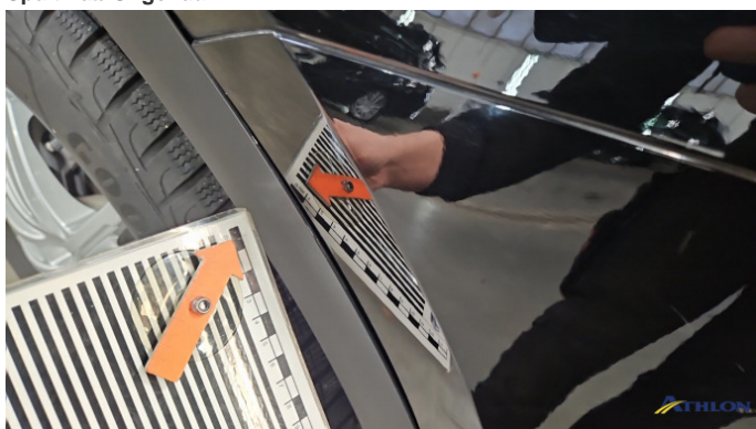
10. Radlaufabdeckung Hinten Links Spaltmaß Ungenau
